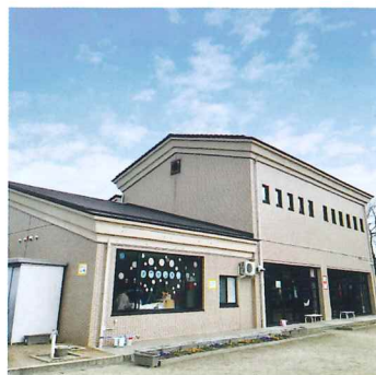
職員室から外も常時確認できる
